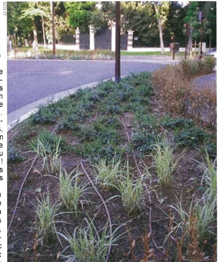
En optant pour des lignes de goutteurs, l'installateur doit veiller à ce qu'elles soient ni trop resserrées, ni trop distancées. Un point essentiel pour éviter la surconsommation d'eau.
